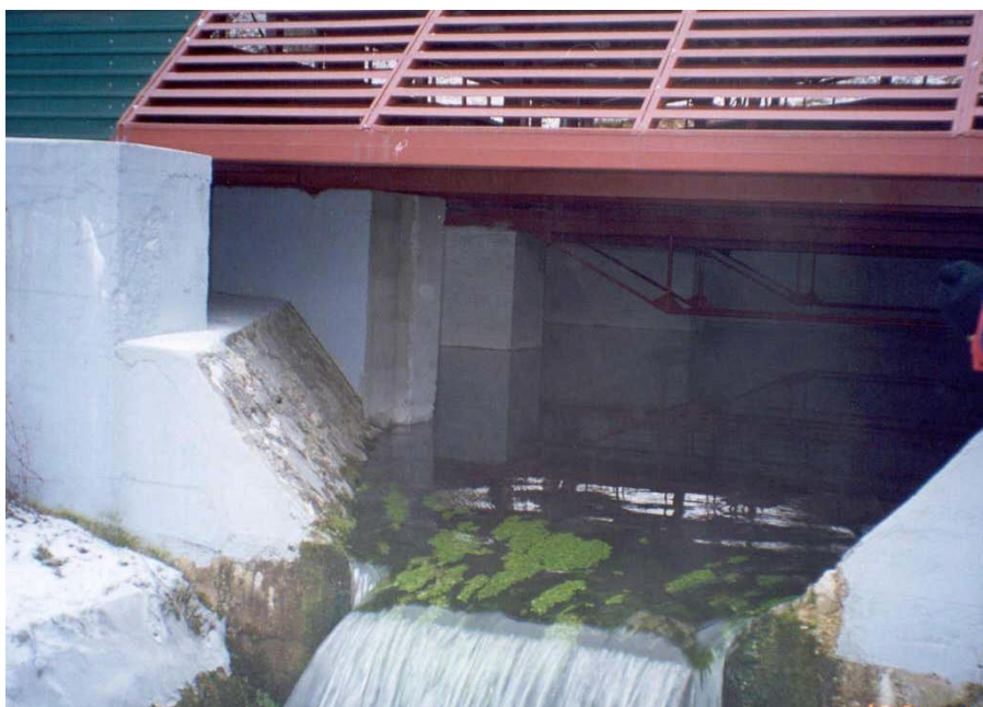
Vodozahvat na uzlaznom izvoru
